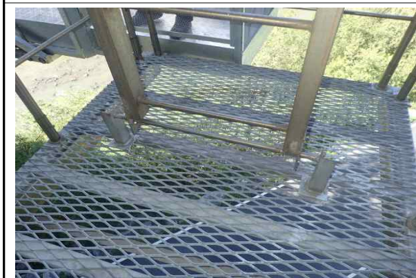
점검시설 출입사다리 고정상태 등 양호
