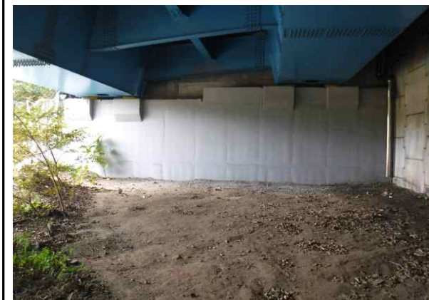
교대(A1) 전경 (상행)
