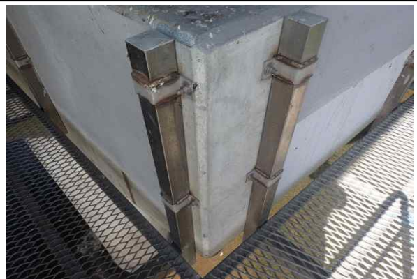
점검시설 통로, 발판 고정상태 등 양호
